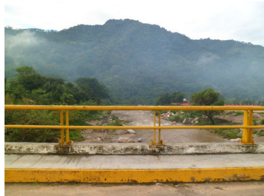
Puente que conecta al Barrio Piedra del Sol.
