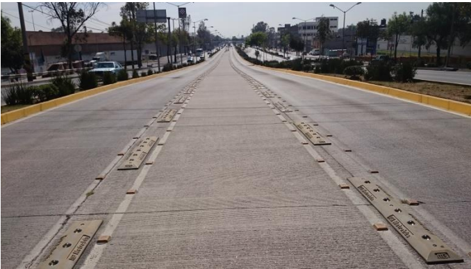
Fotografía 7. Confinamiento en Línea 3. Se muestra el confinamiento de tipo canaleta. Autor: Antonio Carlos González Coronado.
