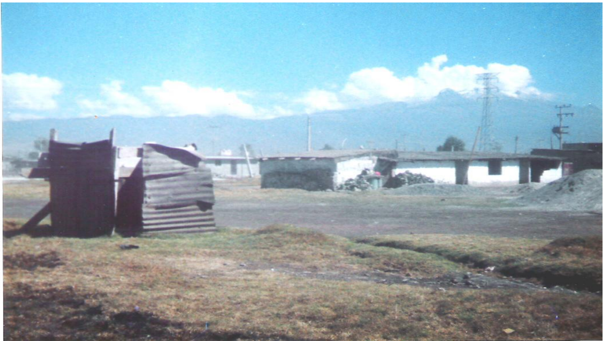
Escuela en construcción. Jardines de Chalco
