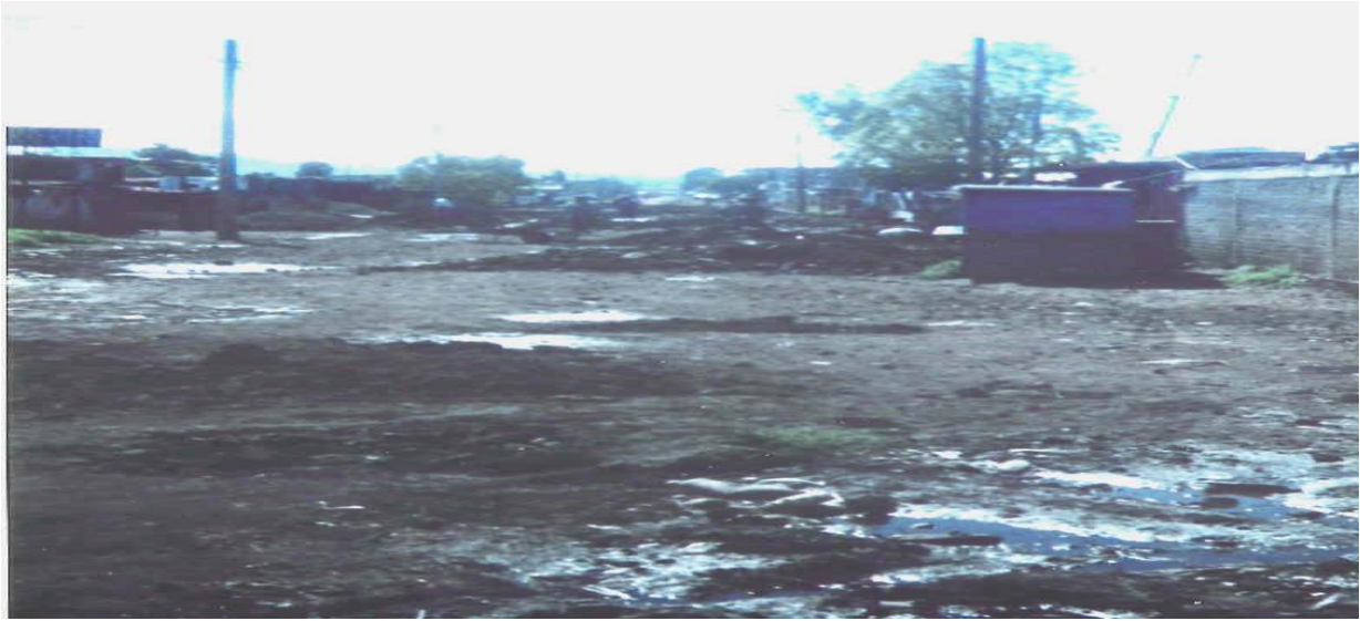
Excavaciones para drenaje. Jardines de Chalco
