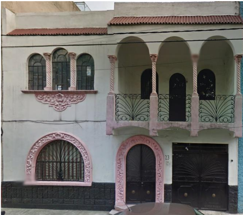
Figura 48. Casa al estilo neocolonial con sus techumbres inclinadas, con paramentos blancos y lisos, columnas salomónicas y arreglos sencillos, pero que a veces remite a la exuberancia del barroco en los marcos de las ventanas y puertas. Por a su alto costo de producción, se extendió en las colonias de clase alta y media como la Guadalupe Tepeyac (Sánchez, 1999).
