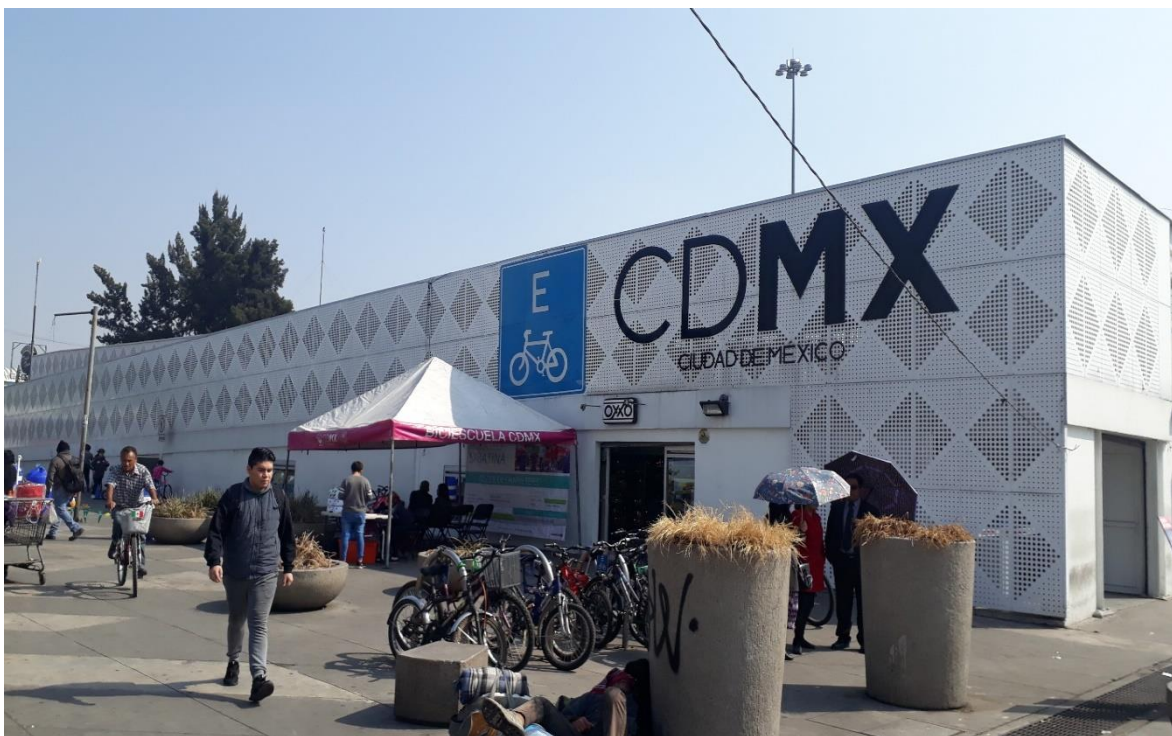
Figura 18. Infraestructura del Bici-estacionamiento masivo
