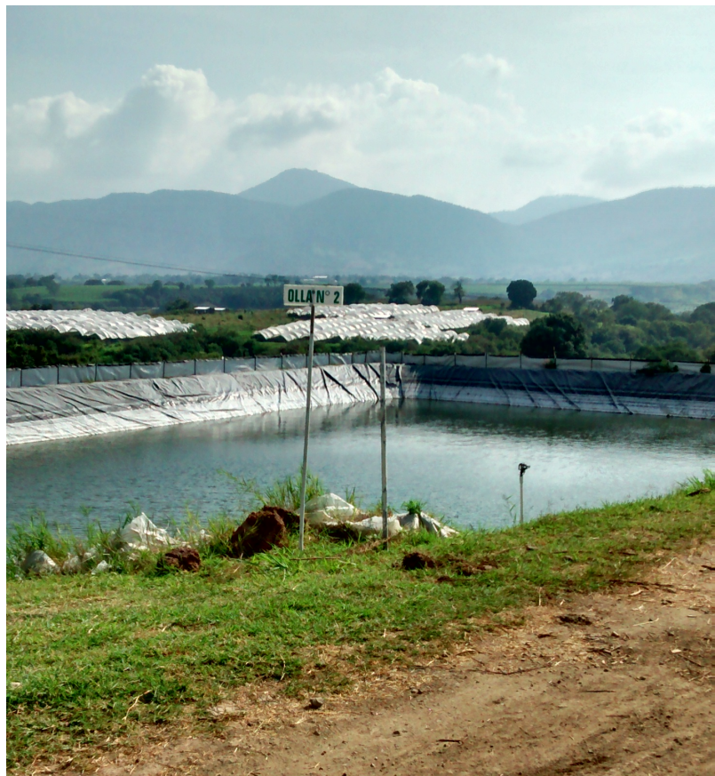
Olla de contención de agua para riego por goteo.
