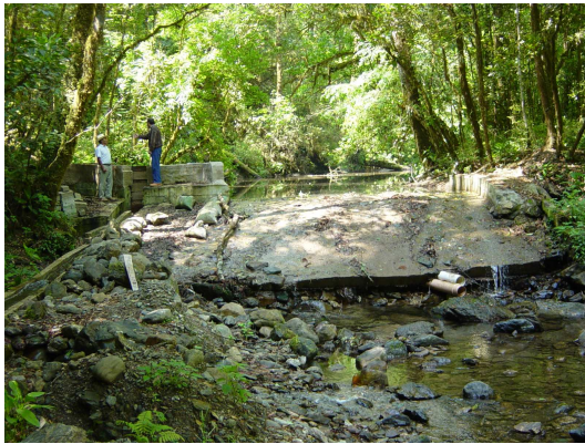
Foto 6. Toma de agua
