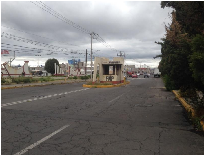
Fotografía 21. Entrada de Los Héroes Tecámac sección Jardines
