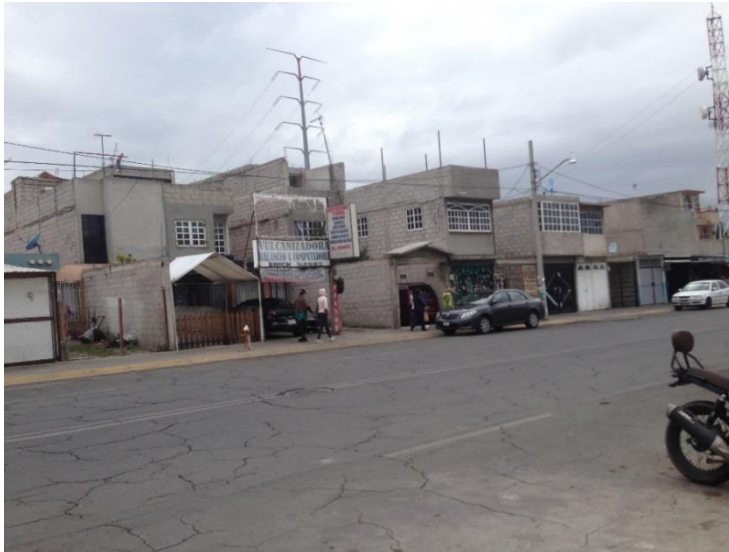
Fotografía 14. Construcción de barda en un domicilio en sección Jardines
