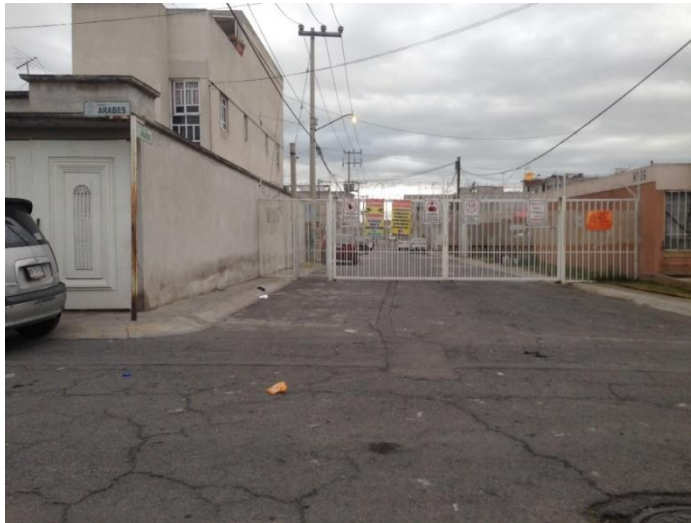
Fotografía 4. Calles de sección Jardines con rejas de acceso.
