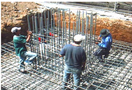
ARMADO Y COLADO DE CIMENTACIONES PARA TORRES DE TELEFONIA CELULAR
