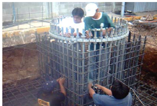
ARMADO Y COLADO DE CIMENTACIONES PARA TORRES DE TELEFONIA CELULAR
