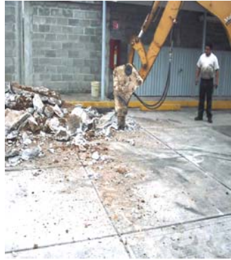
CORTE FIRME DE CONCRETO
