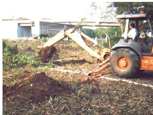
EXCAVACIONES A TREVÉS DE MEDIOS MECANICOS
